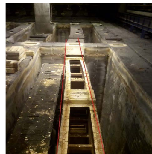
Рисунок 4 – Наиболее искривленный простенок (49 мм) 7 простенок камеры № 5
