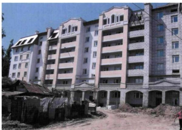
Рисунок 1 – Объект внедрения – жилой дом № 33 по ул. Майры г. Павлодар с наружными несущими стенами из мелких ячеистобетонных блоков
