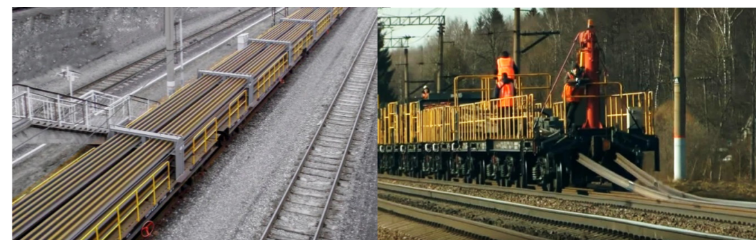
Рисунок 1 – Перевозка (а) и укладка (б) длинномерных рельсовых плетей
