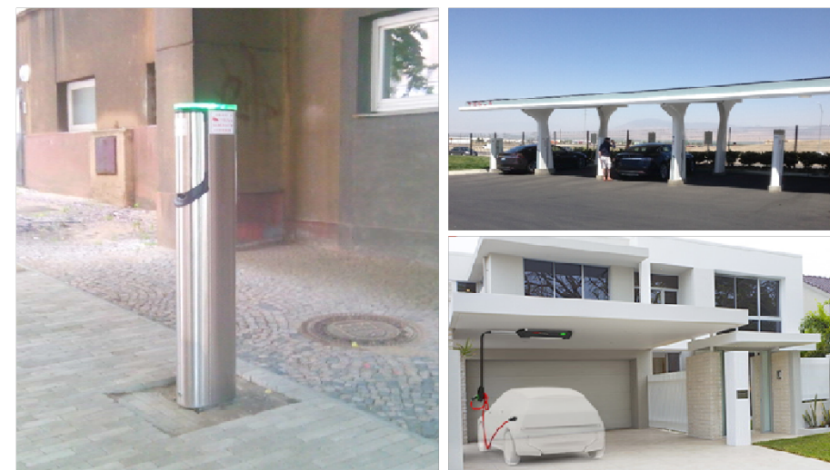
Рисунок 6 – Примеры станций зарядки электромобилей: корпоративная станция на транспортном факультете, СТУ в Праге (слева), общественная зарядная станция Tesla с источником солнечной энергии (вверху справа), домашняя зарядная станция Easycharge (внизу справа)
