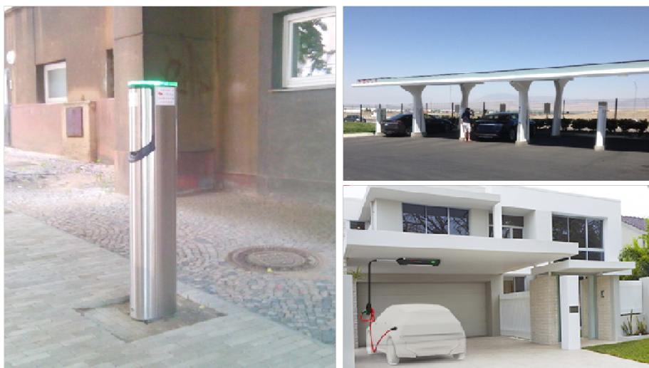
Рисунок 6 – Примеры станций зарядки электромобилей: корпоративная станция на транспортном факультете, STU в Праге (слева), общественная зарядная станция Tesla с источником солнечной энергии (вверху справа), домашняя зарядная станция Easycharge (внизу справа)
